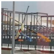
Lavori in corso al cantiere di Expo 2015
