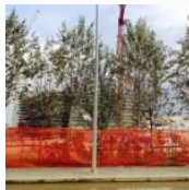
Costruzione di Palazzo Italia, Cantiere Expo 2015
